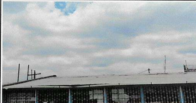
Sustitución de lamina por lamina troquelada
