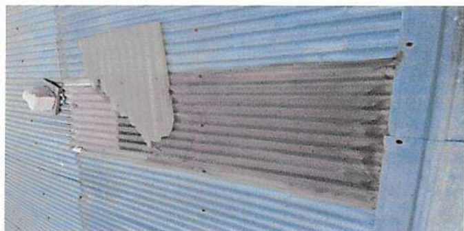
Sustitución de lamina por lamina troquelada
