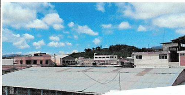
Sustitución de lamina por lamina troquelada
