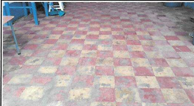
Sustitución de piso de granito modulo 2 salón principal
