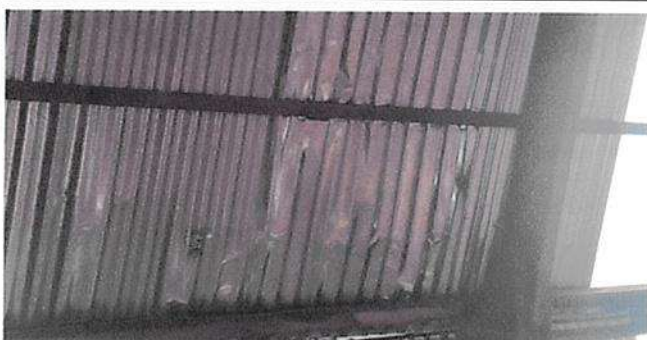
Sustitución de lamina por lamina troquelada
