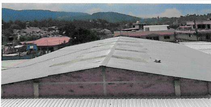
Sustitución de lamina por lamina troquelada
