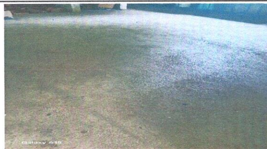
Foto 4: Mantenimiento sustitución de piso de concreto a piso cerámico
