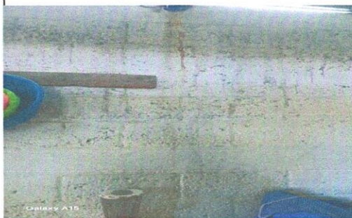
Foto 2: Repello en muro en interior de cocina
