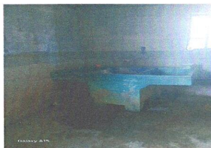
Foto 6: Sustitución de pila por lavatrastos.
