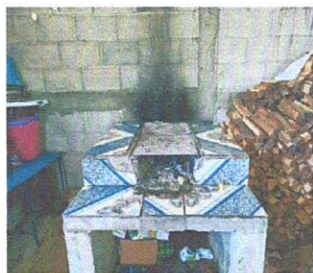
Foto 1: Sustitución de plancha en cocina
