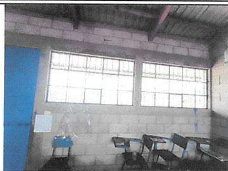
Mantenimiento de muro con repello en interior de aulas
