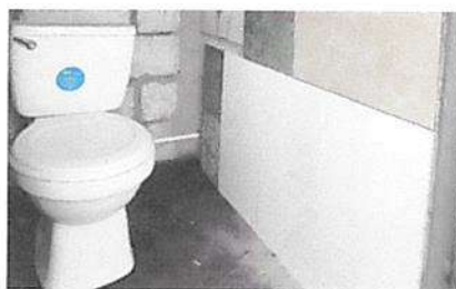
Suministro de inodoro y accesorios en baños elongado con push
