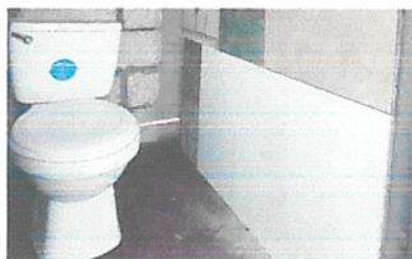
Sustitución de inodoro y accesorios en baños elongado con push y accesorios en inodoro (contra llave, tubo de abasto, flotado de tanque, válvula de llenado).
