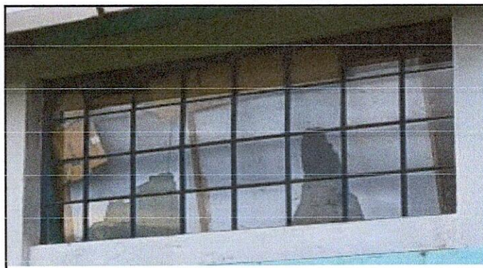
Mantenimiento de balcones de metal de 1.22 por 2.22 metros.
