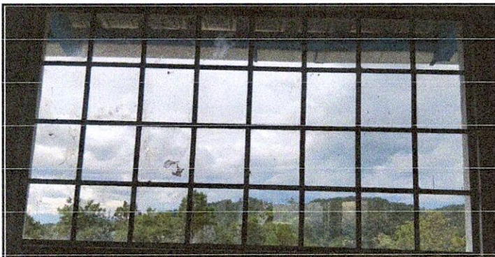
Sustitución de ventana de PVC de 1.22 por 2.22 metros, con cedazo y vidrio claro de cinco mm
