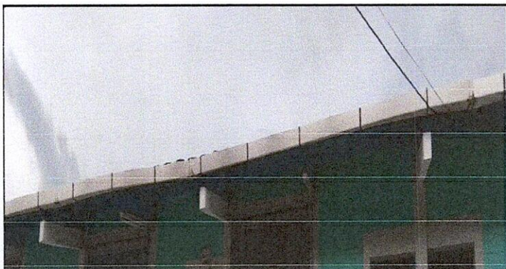
Mantenimiento de canal de PVC
