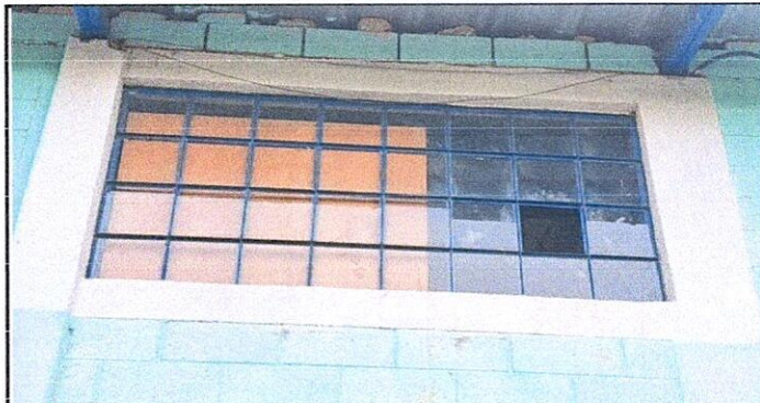
Sustitución de ventana de PVC de 1.22 por 2.22 metros, con cedazo y vidrio claro de 5 mm
