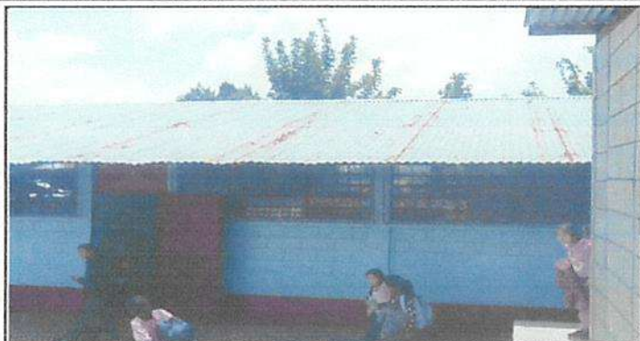
Mantenimiento de techo de de las aula de la escuela con pintura
