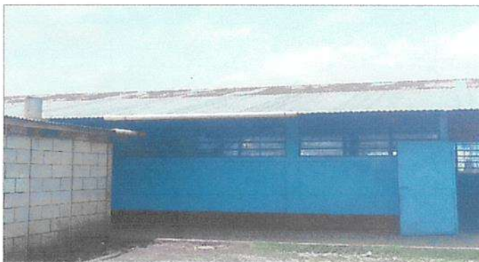
Suministro y aplicación de pintura exterior e interior en aulas de la escuela
