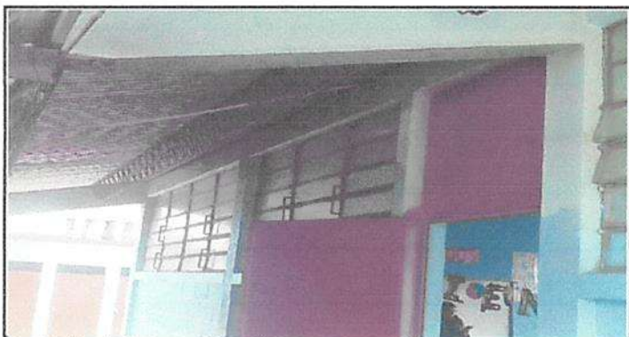
Sustitucion de balcones de 8 aulas
