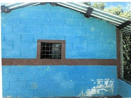
Repello alisado de paredes internas y externas de cocina
