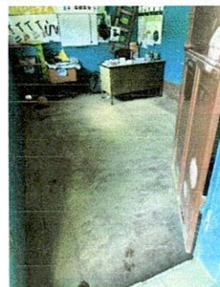
Sustitución de piso de concreto existente en cocina y aula por piso cerámico antideslizante de 0.40 m x 0.40m
