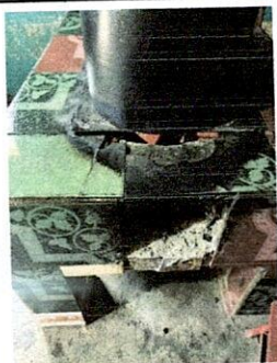
Mantenimiento de estufa a leña existente en cocina de 1.00m X 1.50 m, sustituyendo el azulejo existente por uno nuevo de 0.20 x 0.20m con, incluye sustitución de plancha existente por una nueva plancha de 3 quemadores de metal de 20" x 36" , incluye el mantenimiento y limpieza de chimenea existente.
