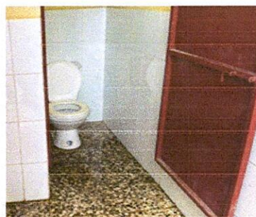
Sustitución de inodoro estandar baby blanco y accesorios. 1 unidad
