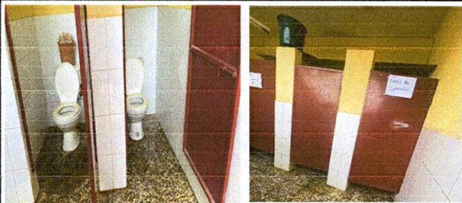
Sustitución de inodoros alargados y accesorios. 5 unidades
