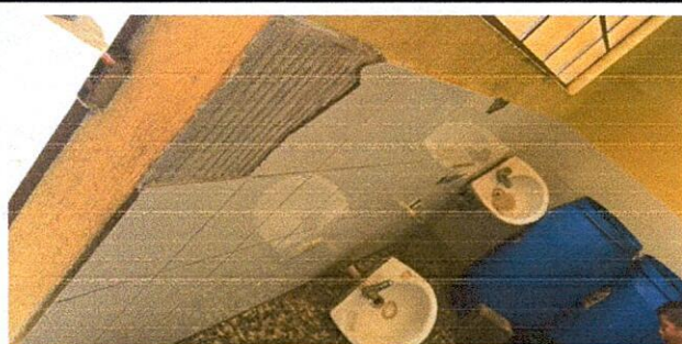
Sustitución de azulejo en baños de hombres y mujeres 55 m2
