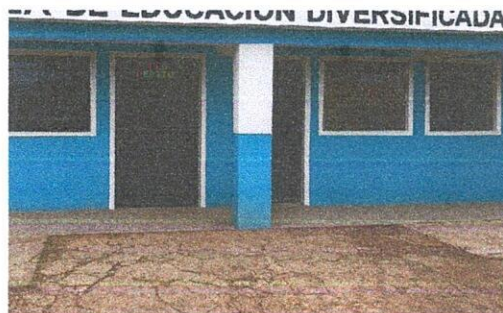
Sustitución de pavimentacion del patio y entrada del centro educativo con un e = 0.10 m.(280 m2). Sustitución de balcones en ventanas del centro educativo de diferentes medidas (10 unidades)
