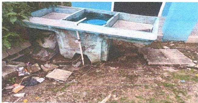
Reparación de drenaje de la pila con tubo PVC de 3" y caja de registro
