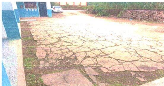
Sustitución de pavimentacion del patio y entrada del centro educativo con un e = 0.10 m.(280 m2)
