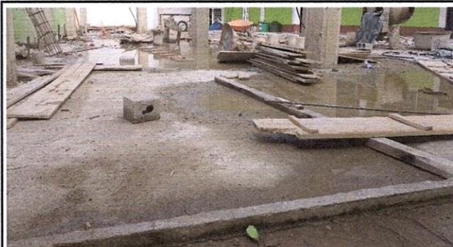
Mantenimiento correctivo de muros con repello y cernido (suministro de materiales)
