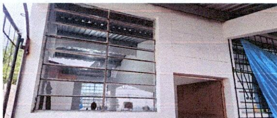
Sustitución de balcones en ventanales de diferentes aulas. (13 m2)
