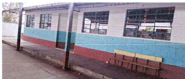
Mantenimiento preventivo de balcones de metal solido. (13 m2)
