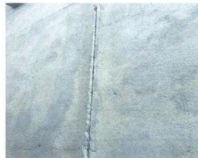
Mantenimiento y sustitución de piso de concreto a piso cerámico
