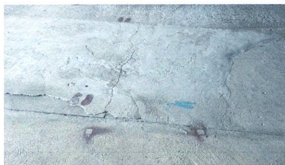
Mantenimiento y sustitución de piso de concreto a piso cerámico
