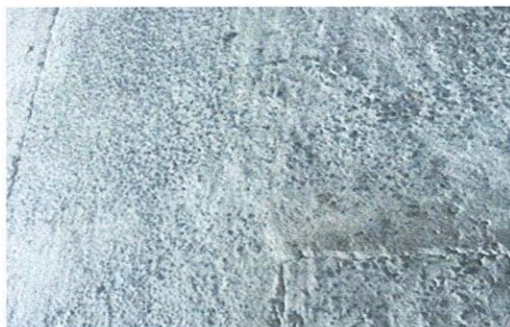
Mantenimiento y sustitución de piso de concreto a piso cerámico
