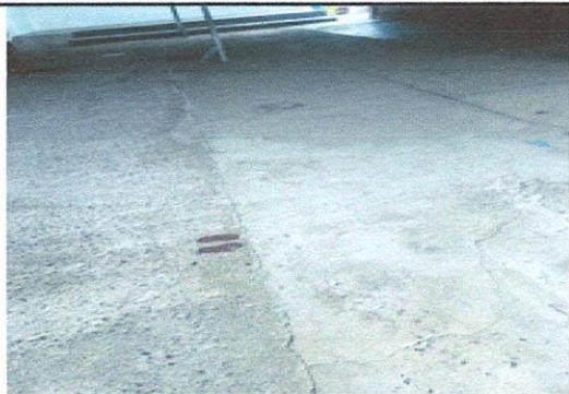
Mantenimiento y sustitución de piso concreto a piso cerámico
