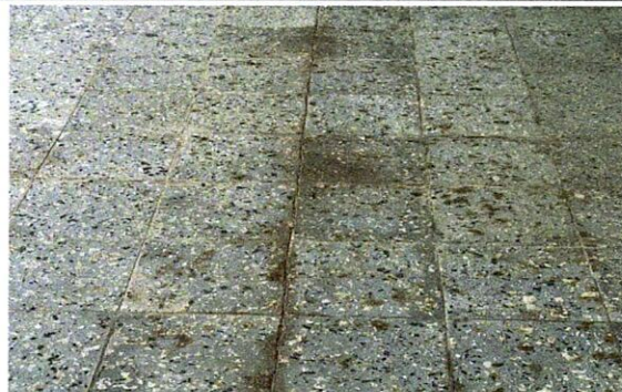
Sustitución de piso granito de marmol a piso cerámico
