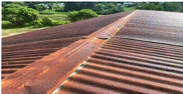
Sustitución de lamina acanalada por lamina troquelada calibre 26 color rojo
