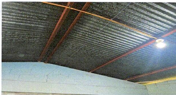
Mantenimiento de costaneras de estructura portante (lijado, pintura)
