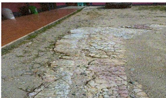
Mantenimiento correctivo de planchas de concreto en patio de modulo 1, cocina y baños
