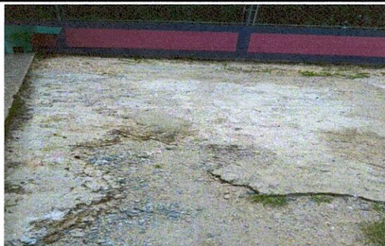
Mantenimiento correctivo de planchas de concreto en patio de modulo 1, cocina y baños
