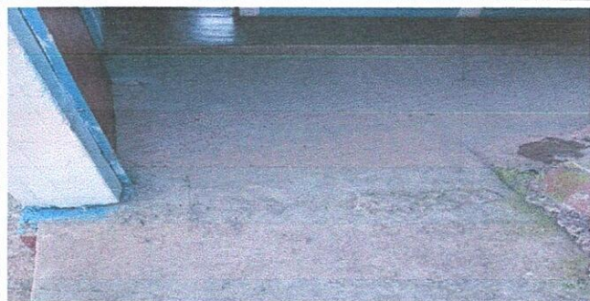
Sustitución de piso de concreto a piso porcelanato en 6 aulas y pasillo del segundo nivel
