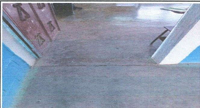
Sustitución de piso de concreto a piso porcelanato en 6 aulas (3 del primer nivel y 3 del segundo nivel) y pasillo del segundo nivel
