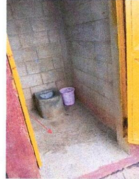
Sustitución de piso de concreto a piso cerámico antideslizante en baños
