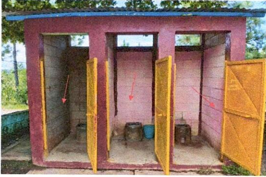
Sustitución de azulejo en baños
