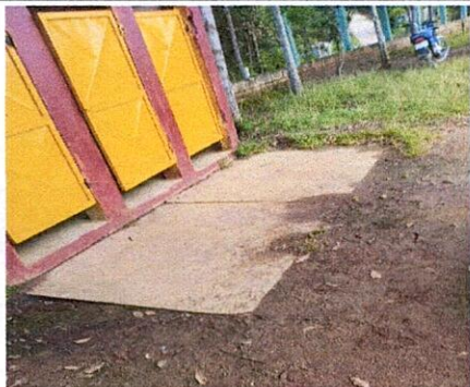
Mantenimiento de plancha de concreto del baño
