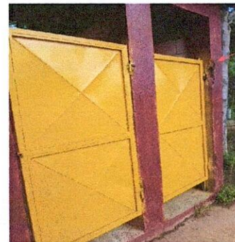
Mantenimiento a estructura de puertas para baño (sujeciones, soldar y fundir)
