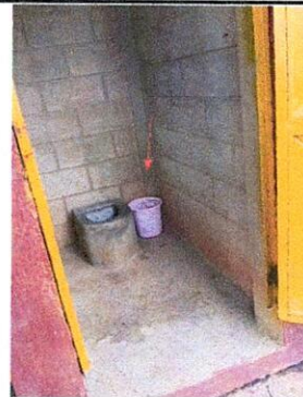
Sustitución de Mingitorio
