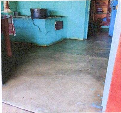
Sustitucion de piso de concreto por ceramico de cocina
