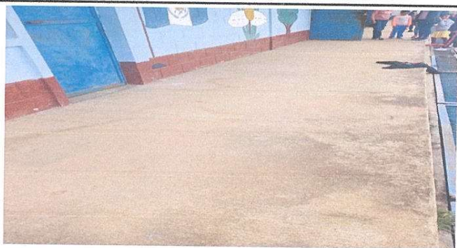
Sustitución de piso cemento a piso antideslizante en pasillo
