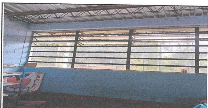
Matenimiento de balcones de ventanas
