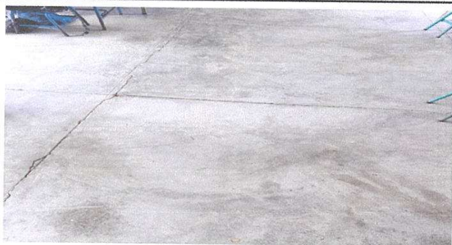
Sustitución de piso cemento a piso cerámico en aulas
