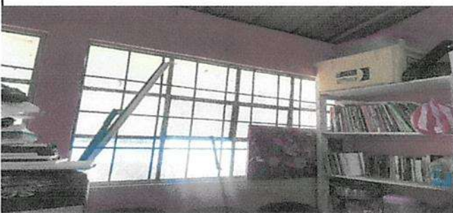
SELLO PERIMETRAL ENTRE TECHO Y LAMINA
