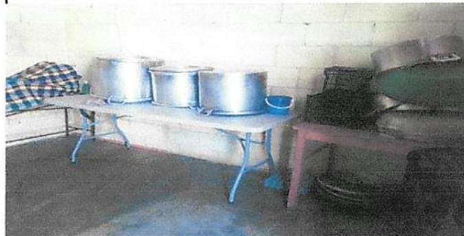
SUMINISTRO DE MATERIALES PARA MESA DE TRABAJO + AZULEJO EN AREA DE COCINA
