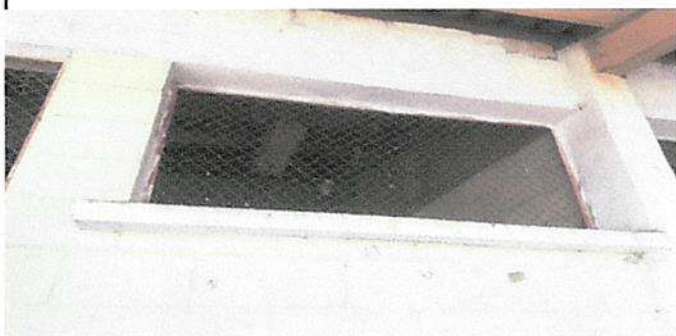
INSTALACION DE VENTANA DE PVC Y MOSQUITERO
