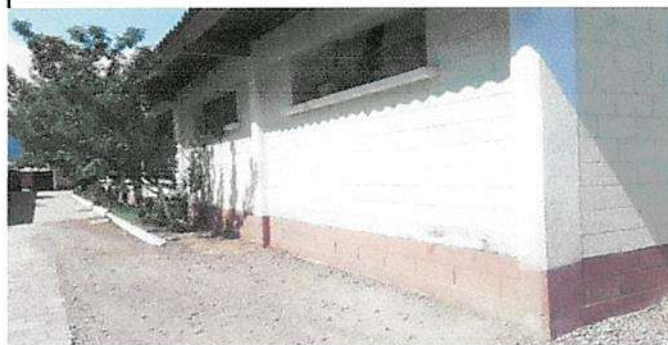
INSTALACION DE CASITA PARA GAS PROPANO
