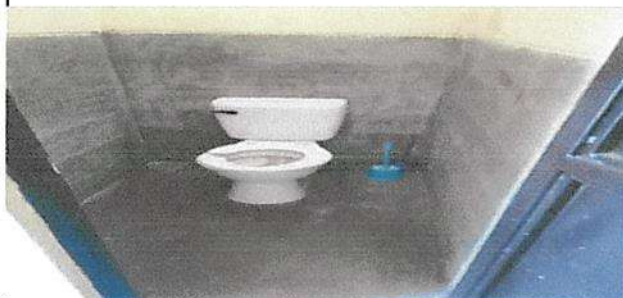
SUSTITUCION DE INODORO
