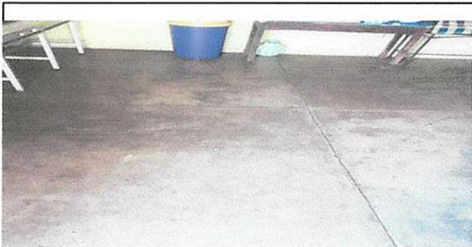
INSTALACION DE PISO PORCELANATO EN EL AREA DE COCINA
