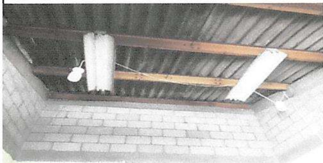
SUMINISTRO Y APLICACIÓN SELLO PERIMETRAL ENTRE TECHO Y LAMINA (cocina), SUMINISTRO DE MATERIALES PARA MESA DE TRABAJO + AZULEJO EN AREA DE COCINA
