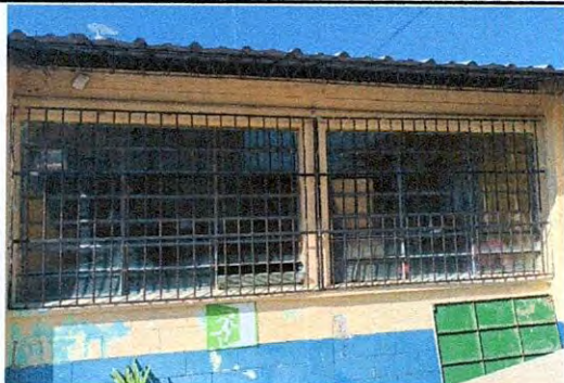
sustitución de dos ventanas de metal a PVC corrediza de 2.17m de largo por 1.50 de ancho
