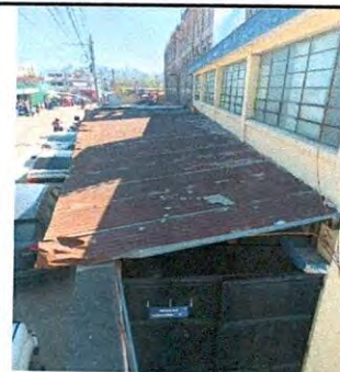
sustitucion de lamina por lamina troquelada calibre 24
