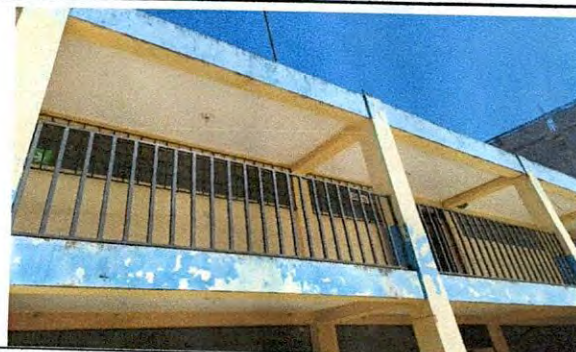
manrtenimiento de baranda de metal en pasillo ( lijado, pintado, y cambio de partes de perfiles afectado.
