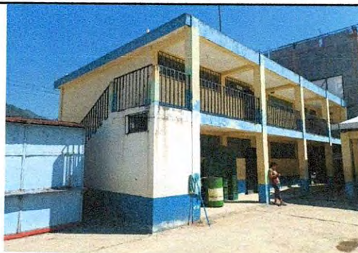
suministro y aplicación de pintura exterior celeste pantone 293
