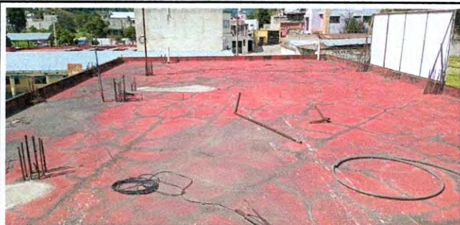
impermeabilizacion de losa con cemento asfaltico
