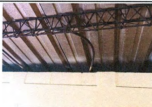
mantenimiento correctivo de cenefa con block de 14x19x39 cm en cocina
