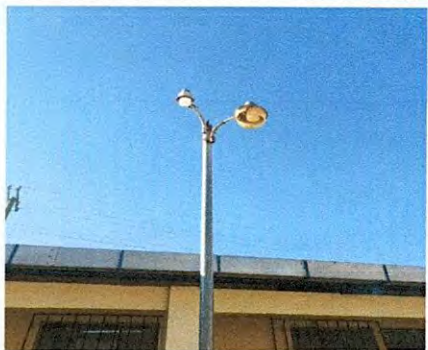
Sustitución de lamparas tipo canasta por lamparas tipo cobra
