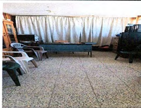
sustitucion de piso de granito por piso ceramico
