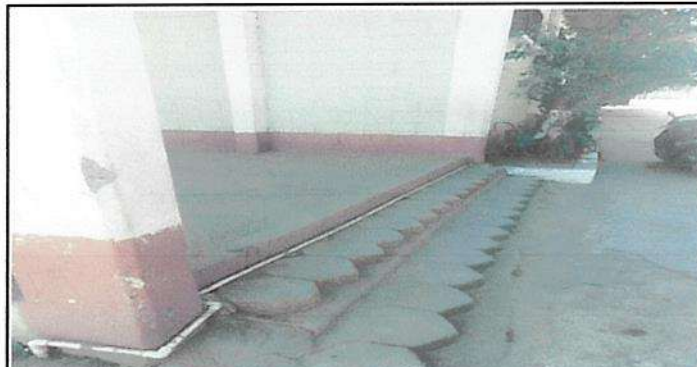
Sustitución de tubería PVC 1/2 " línea principal
