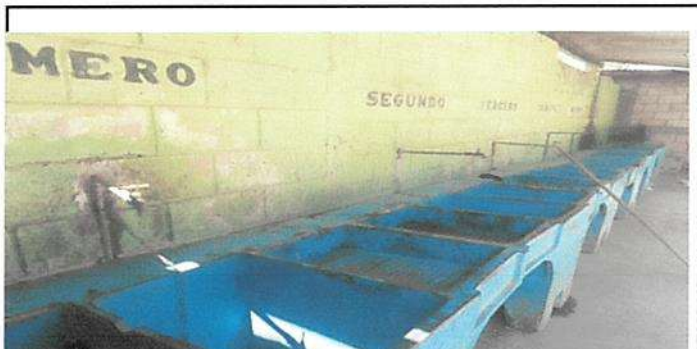
Suministro e instalación de grifos americanos en pilas y lavamanos
