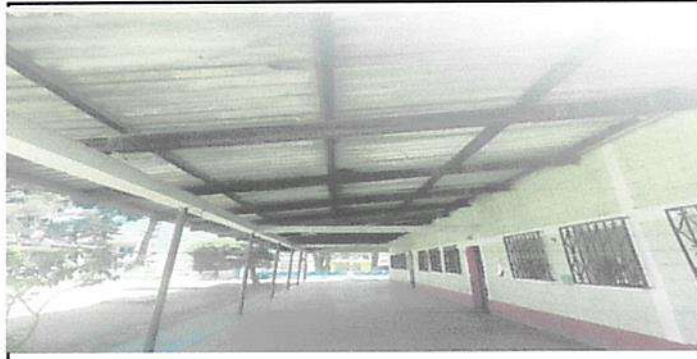
Sustitución de estructura de soporte madera por metal solo costaneras modulo 1
