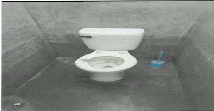
Sustitución de inodoro elongado, baños
