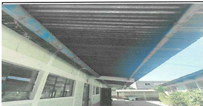
Mantenimiento de estructura de soporte de metal con anticorrosivo, modulo 2
