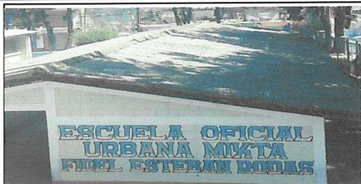
Sustitución de Lámina troquelada calibre 26, modulo 1
