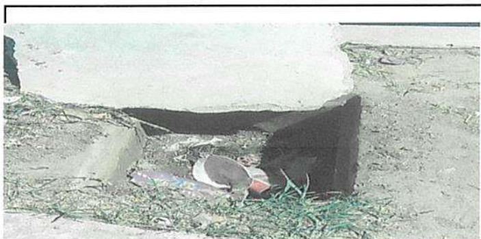
Suministro e instalación de llaves de paso
