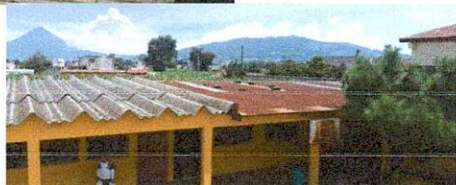
Sustitución de capote de lámina para lámina troquelada calibre 26 módulo salón, Sustitución de lámina, por lámina troquelada calibre 26 módulo aulas
