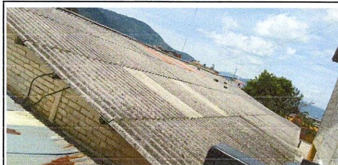
Sustitución de lámina, por lámina troquelada calibre 26 módulo salón
