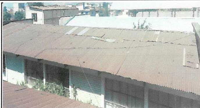
Sustitución de lámina troquelada calibre 26, modulo 3
