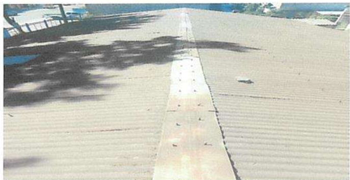
Sustitución de lámina troquelada calibre 26, modulo 2
