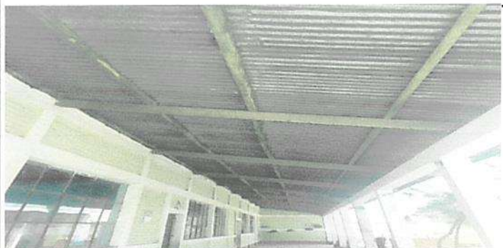
Sustitución de Estructura de soporte de madera por metal, solo constaneras modulo 3
