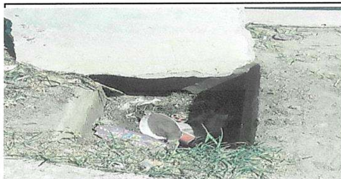
Suministro e instalación de llaves de paso
