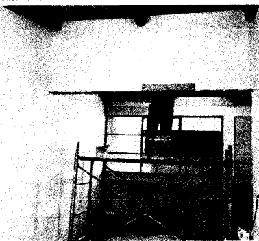
Foto 3: Mantenimiento correctivo de cernido en muros 60 m2
