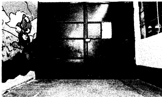
Foto7: Mantenimiento preventivo portón metalico 5.88 m2
