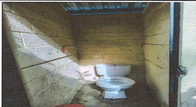
MANTENIMIENTO E INSTALACIÓN DE PISO EN ÁREA DE BAÑOS Y MINGITORIO
