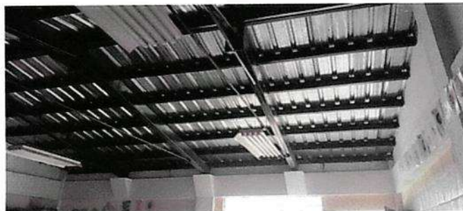
Sustitución de lámparas por Panel led de 40w 1x4 pies en módulos 1 y 2 segundo nivel
