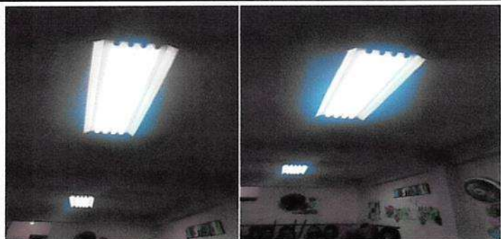
Sustitución de Bombillo LED GLOBO 30W 2400 Lúmenes en modulo 1 primer nivel
