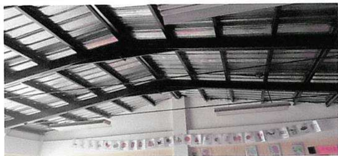
Reparación de cubierta con cielo falso de PVC en módulos 1 y 2 segundo nivel, Sustitución de ventilador de pared de 16 pulgadas en módulos 1 y 2 segundo nivel
