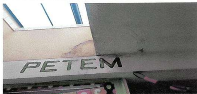
Reparacion de fuga de agua en area de baños segundo nivel
