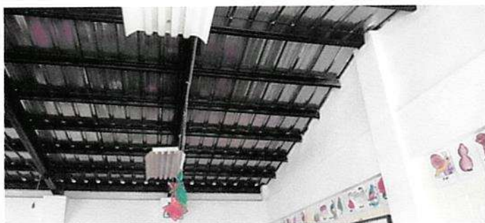
Sustitución de ventilador de pared de 16 pulgadas en módulos 1 y 2 segundo nivel
