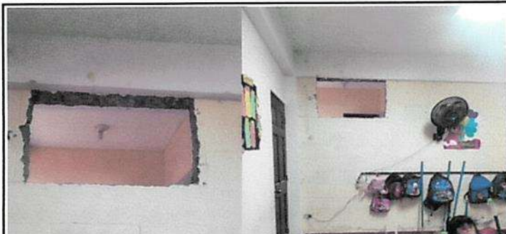
sustitucion de ventana metal por ventana pvc en modulo 1 primer nivel
