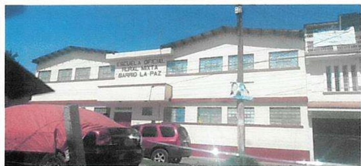
Suministro y aplicación Pintura exterior látex Azul Pantone 293 para zócalo 4 hiladas en fachada principal del establecimiento
