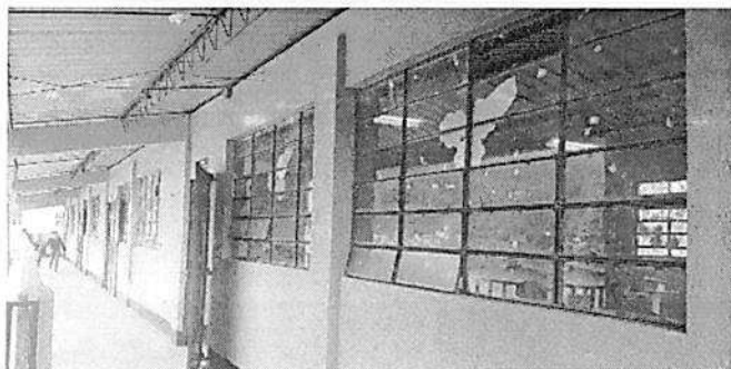
Refuerzo del vano de ventanas frontales con instalación de balcones en modulo de aulas, 3 en primer nivel y 5 en segundo nivel.
