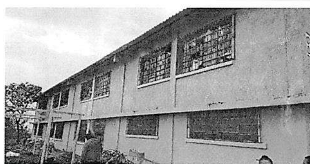
Remozamiento de balcones traseros con pintura anticorrosiva en módulo de aulas, 8 en segundo nivel y 8 en primer nivel
