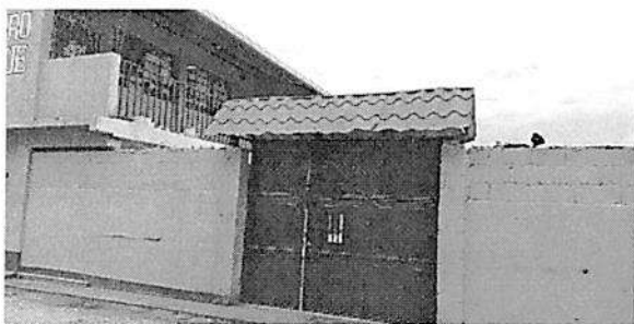
Remozamiento de muro perimetral con tubo y malla galvanizada más solera en parte frontal de la escuela
