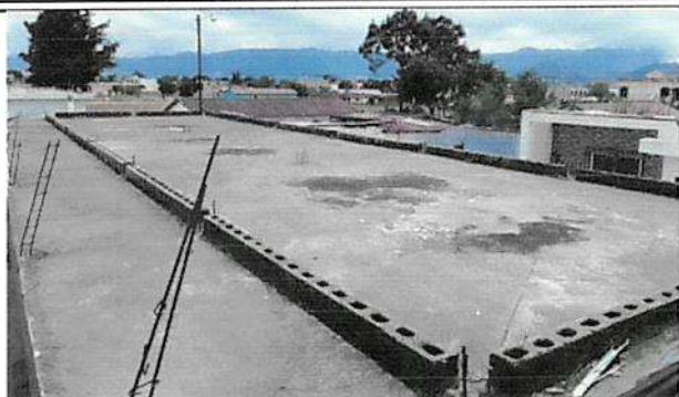
MANTENIMIENTO DE LOSA CON ACIDO MURIATICO, Y APLICACIÓN DE IMPERMEABILIZANTE DE TRIPLE CAPA
