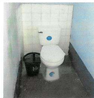
SUSTITUCIÓN DE INODORO ELONGADO + ACCESORIOS EN SERVICIO SANITARIO
