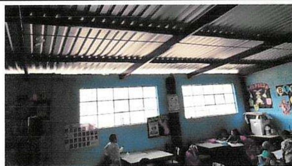
SUMINISTRO Y APLICACIÓN DE SELLO VERTICAL ENTRE MURO Y LAMINA, MODULO 2
