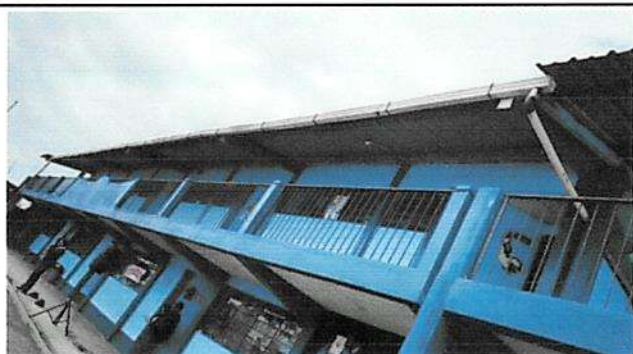
SUSTITUCIÓN CANAL PVC ALTO CAUDAL, INCLUYE BAJANTE PVC Ø 2" COLOR BLANCO EN SEGUNDO NIVEL, MÓDULO 1
