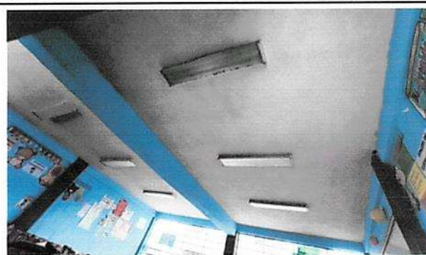
SUSTITUCIÓN DE TUBOS FLUORESCENTES POR TUBO LED 1'x4' 18 W/120V PRIMER NIVEL, MÓDULO 1
