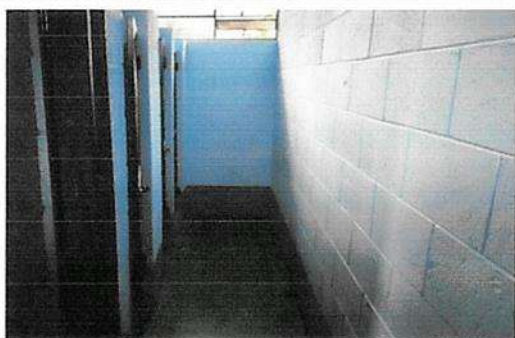
SUMINISTRO E INSTALACIÓN DE AZULEJO EN MUROS DE 1.70 M, SERVICIO SANITARIO
