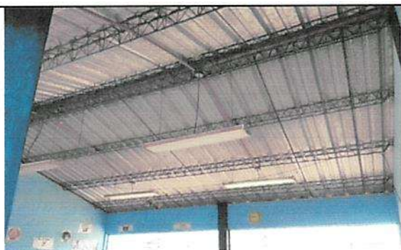
SUSTITUCIÓN DE TUBOS FLUORESCENTES POR TUBO LED 1'x4' 18 W/120V SEGUNDO NIVEL MÓDULO 1
