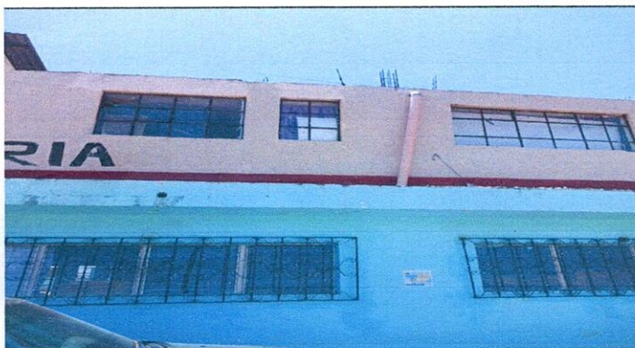
Sustitución de tubería (Área de peña para la salida a la calle)
