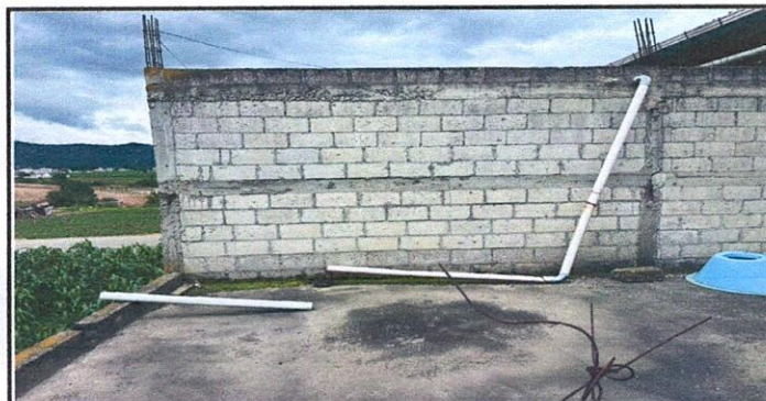
Sustitución de tubería (Área de la losa)
