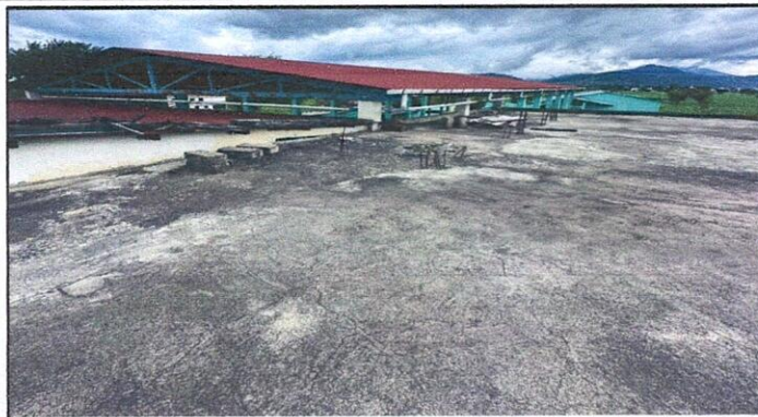
Mantenimiento de losa (Impermeabilizante)
