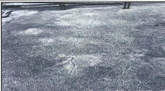
Mantenimiento de losa
