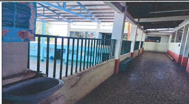
Sustitución de tuberías ( Área frente a las aulas)
