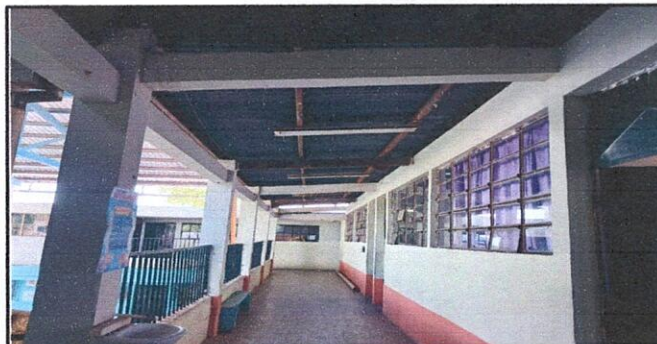
Mantenimiento de pintura ( Segundo Nivel)
