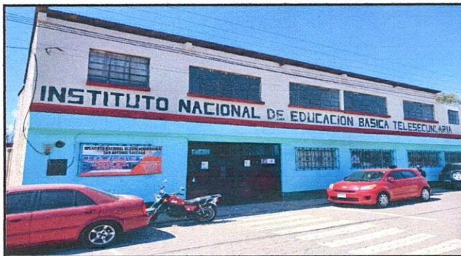
Mantenimiento de pintura
