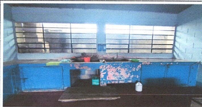
Foto 3: Sustrucción de ventana de metal a ventanas UPVC color blanco con vidrio de 5 mm y cedazo en cocina
