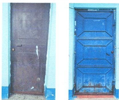
Foto 5: Mantenimiento de puertas (lijado, pintura)
