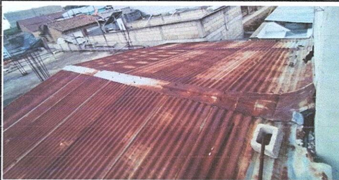
Foto 1: Sustrucción de lámina, por lámina troquelada Calibre 26 en cocina
