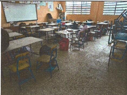
SUSTITUCION DE PISO DE GRANITO POR PISO CERAMICO DE 20X66 MARCA BORDO EN 3 AULAS
