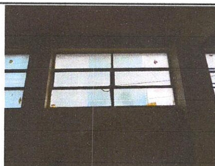
MEJORAMIENTO CORRECTIVO EN VENTANA CON CEDAZO
