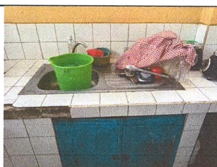
SUSTITUCION DE LAVATRASTOS POR PILA DE LAVADO DE OLLAS DE 1.10 M DE ANCHO X 0.85 M DE ANCHO X 0.45 CM DE PROFUNDIDAD
