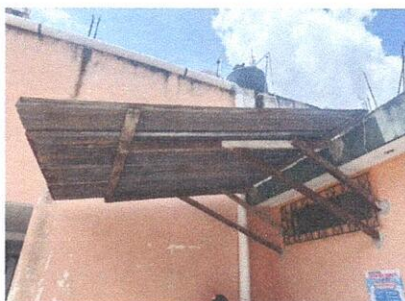
FOTO 9. COLOCACIÓN DE LÁMINA Y REFUERZO DE ESTRUCTURA.
