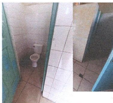
FOTO 3. SUSTITUCIÓN DE LAVAMANOS DE ÁREA DE BAÑOS DE NIÑOS Y NIÑAS, SUSTITUCIÓN DE AZULEJOS EN PARED DE LAVAMANOS.
