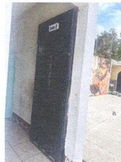
FOTO 8. MANTENIMIENTO DE PUERTAS METÁLICAS.
