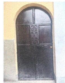
FOTO 10. REPARACIÓN DE PUERTA DE METÁLICA Y CAMBIO DE CHAPA.
