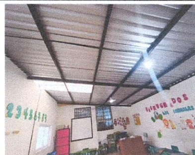
FOTO 6. COLOCACIÓN DE CIELO FALSO.
