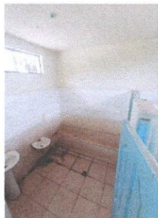
FOTO 1. SUSTITUCIÓN DE PISO EN EL ÁREA DE BAÑOS DE NIÑOS Y NIÑAS, MANTENIMIENTO CORRECTIVO DE AZULEJO.
