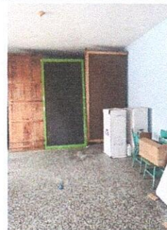
FOTO 4. MANTENIMIENTO CORRECTIVO EN MURO DE MADERA POR PANELES.
