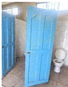
FOTO 7. PINTURA Y MANTENIMIENTO DE PUERTAS DE MADERA.
