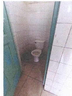
FOTO 2. SUSTITUCIÓN DE TAZAS SANITARIAS DE BAÑOS DE NIÑOS Y NIÑAS, MANGUERAS METÁLICAS PARA CONEXIÓN DE ARTEFACTOS.
