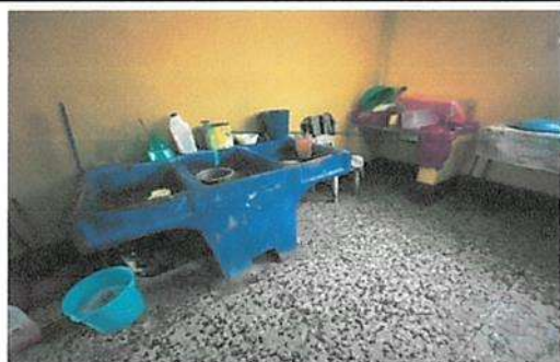
SUSTITUCIÓN DE PILAS DE CONCRETO DE DOS LAVADEROS
