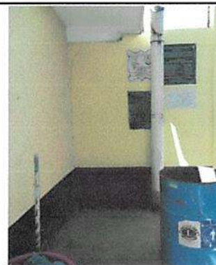
REPARACION DE PARED CON FISURA EN PATIO
