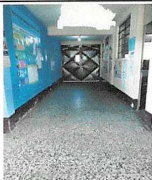
SUSTITUCIÓN DE PISO CERAMICO NACIONAL ANTIDESLIZANTE EN DIRECCION Y PASILLO DE INGRESO
