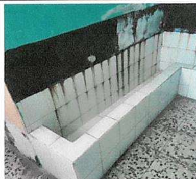
SUSTITUCIÓN DE AZULEJO EN URINAL DE 20X33 EN BAÑO DE HOMBRES
