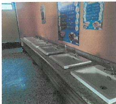
SUSTITUCIÓN DE AZULEJO DE 20X33 EN LAVAMANOS DE HOMBRES
