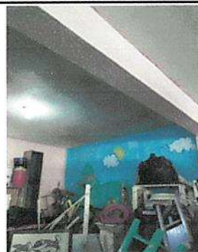
IMPERMEABILIZACION EN TECHO DE CLASE 1
