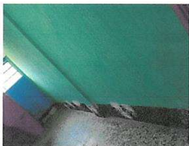
SUMINISTRO E INSTALACION DE AZULEJO DE 20X33 EN BAÑO DE MUJERES
