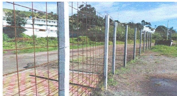
Sustitución de cerco de malla por barda prefabricada de concreto reforzado de h= 2.50 mt (Módulo 1). 69 ml
