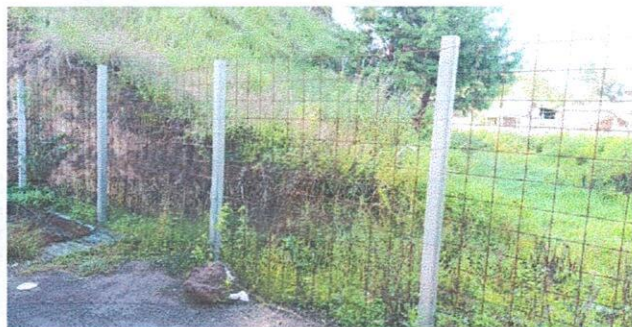
Sustitución de cerco de malla por barda prefabricada de concreto reforzado de h= 2.50 mt (Módulo 1). 69 ml
