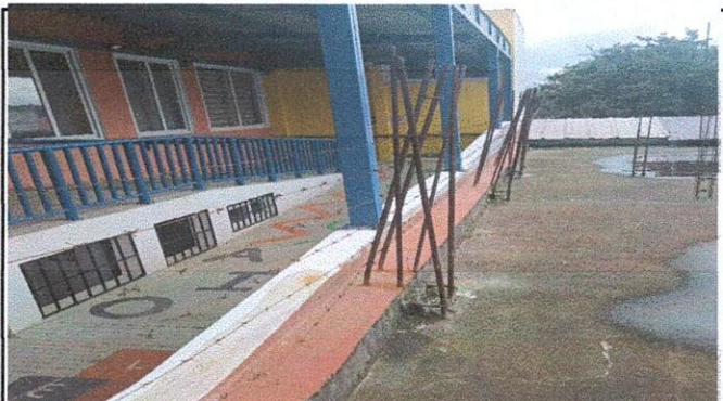
Foto 4: Limpieza y aplicación impermeabilización de losa.
