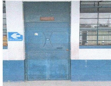
Foto 8: mantenimiento de puertas (lijado y pintura) en aula
