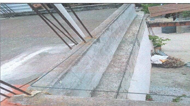
Foto 6: Limpieza y aplicación impermeabilización de losa.
