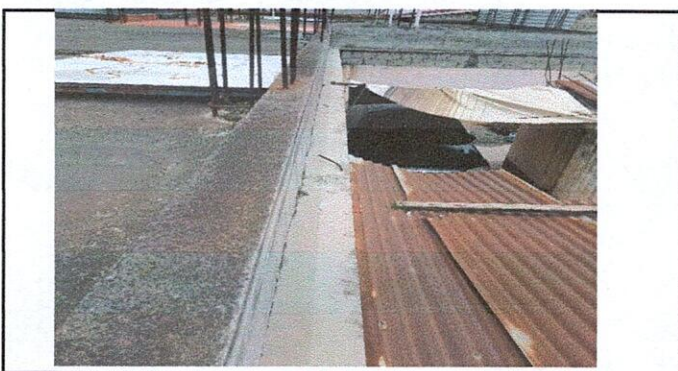
Foto 5: Limpieza y aplicación impermeabilización de losa.
