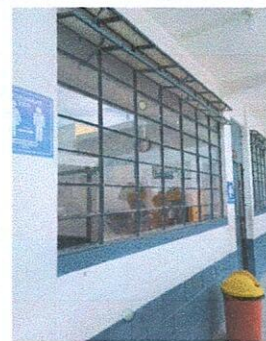
Foto 12: Mantenimiento de ventanas (lijado y pintura) en aulas
