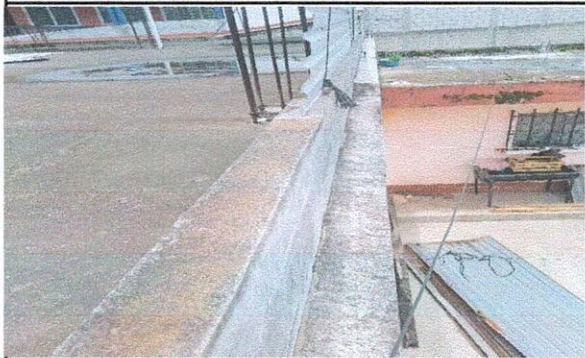
Foto 7: Limpieza y aplicación impermeabilización de losa.
