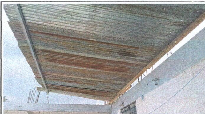
Foto 2: Sustrucción de lámina galvanizada acanalada a lámina troquelada calibre 26 en patio
