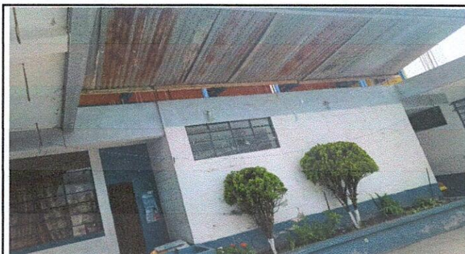
Foto 3: Sustrucción de estructura de techo (Tijeras 4" x 6" ) 9 unidades y costaneras de 4X2" 20 unidades, Instalada en pasillo
