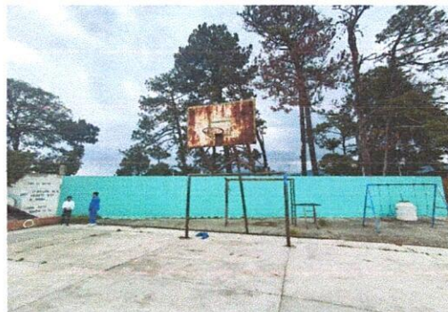
Foto 2: Mantenimiento correctivo de porterías más canasta existente.
