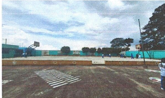
Foto 1: Pintura en cancha polideportiva y marcaje de las áreas
