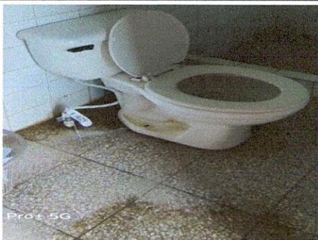
Foto1: Sustitución inodoro elongado
