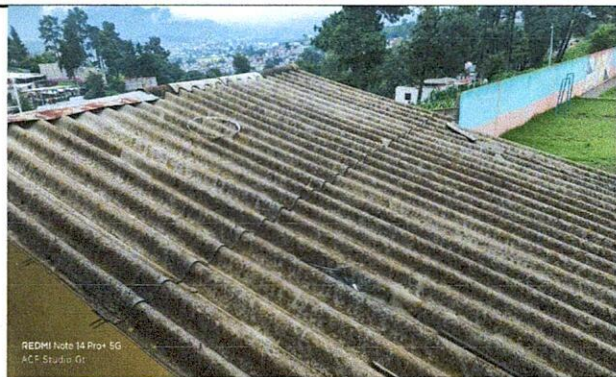
Foto 7: Sustitución de lámina, por lámina troquelada calibre 26m
