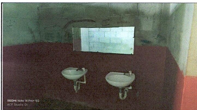
Foto 3: Sustitución lavamanos con grifería sobre pedestal de cemento
