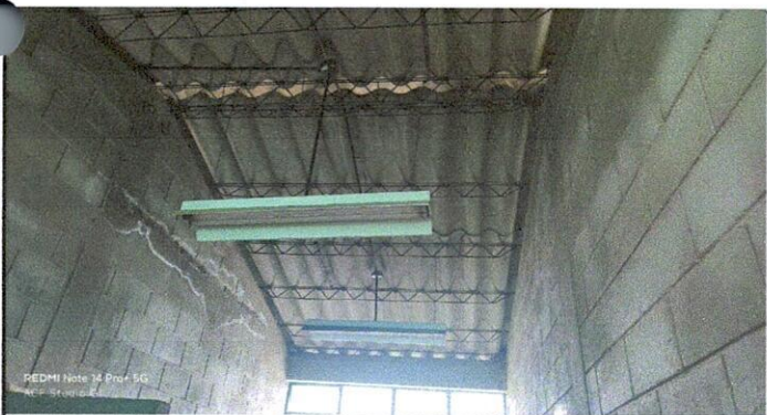
Foto 5: Sustitución de lámparas por lámpara bombillo led globo 30w para pasillos 2,400 lúmenes
