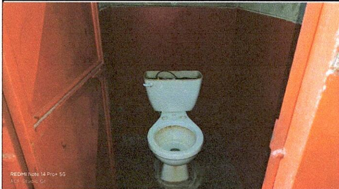
Foto 2: Sustitución inodoro elongado
