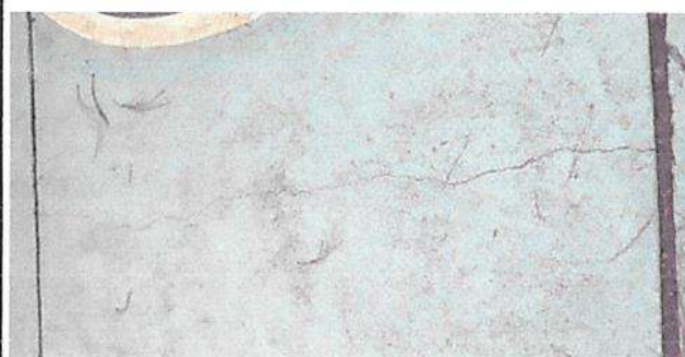
sustitución de piso de concreto T-0.10 mts 3000 psi
