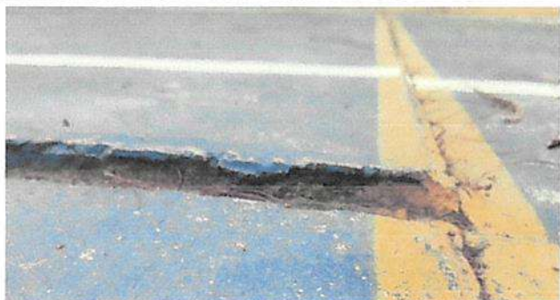
Mantenimiento correctivo de piso de cancha polideportiva
