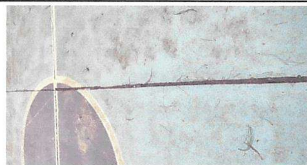
mantenimiento correctivo con corte y sello de juntas
