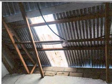
Sustitución de tubería PVC eléctrica (50 ml)
