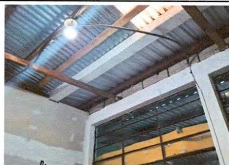
Sustitución de lámparas tipo panel led 40 Watt (2 unidades)
