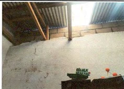
Sustitución de lámina transparente por láminas de policarbonato de 7 pies acanaladas del techo en dirección 2 unidades
