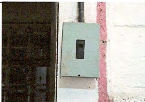
Sustitución de tablero eléctrico de dos flípones en ingreso de dirección
