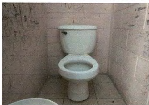
Sustitución de 6 inodoros marca incesa Standard, incluye tubos de abasto y contrallaves
