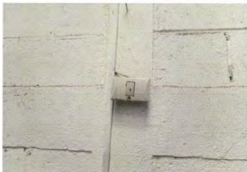
Sustitución de Interruptores dobles marca Eagle (2 unidades)
