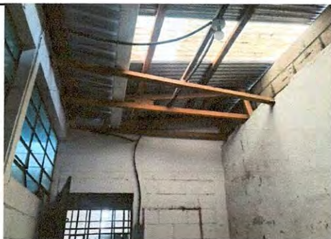
Sustitución de cableado eléctrico AWG 12 (100 ml)
