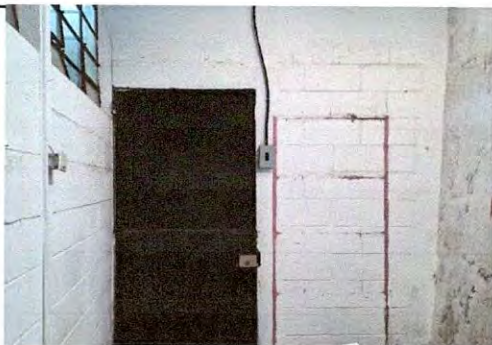
Suministro y aplicación de pintura en el area interior de la dirección y pasillo 80 m2
