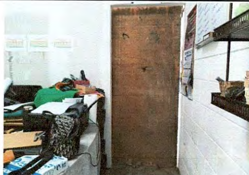
Sustitución de puerta interior prefabricada en dirección 2.10 * 0.90 m color wengue con chapa de manecilla color aluminio marca yale
