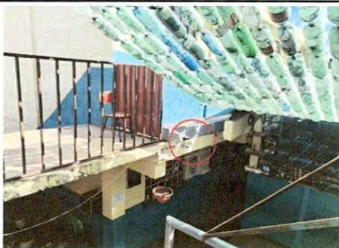
Mantenimiento a drenaje pluvial de 3" (6 m)
