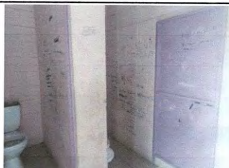
Suministro y aplicación de pintura interior de muros de baños (43 m2)
