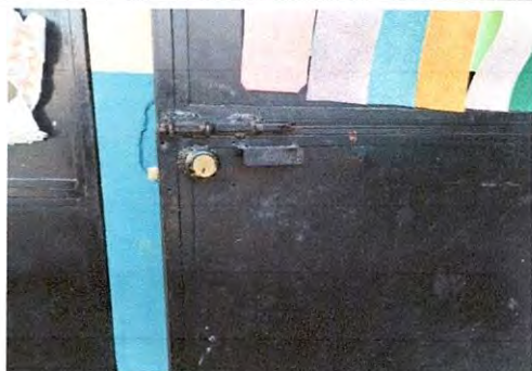
Mantenimiento de puertas de aulas (lijado y pintura) bisagras y sustitución de chapas marca yale
