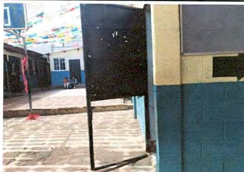
Sustitución de puerta metalica de aula 2.27 * 0.90 m con chapa yale
