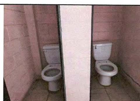
Sustitución de 6 inodoros marca incesa Standard, incluye tubos de abasto y contrallaves
