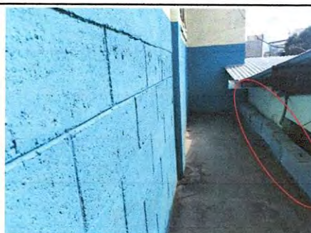
Mantenimiento a muro de block existente en área de losa y bajada de agua + pañuelo 12 ml
