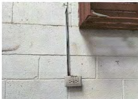
Sustitución de tomacorrientes dobles marca Eagle (2 unidades)
