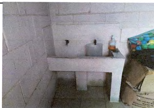
Sustitución de 1 lavamos, tubo de abasto, contrallave y llave de agua Pfister y sifón completo
