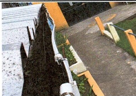
Módulos 2 y 3. Sustitución de canal y bajadas pluviales, se desinstalarán las que están en mal estado Módulos 2 y 3, se instalarán nuevos.
