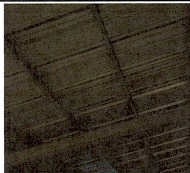
Módulo 2. Instalación de cielo falso en aula nueva.
