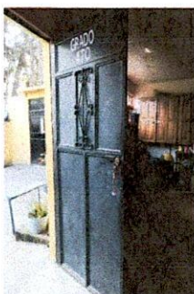
Módulo 3. Sustitución de puerta metálica
