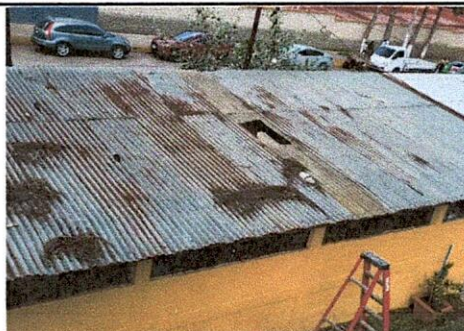
Instalación de canal y bajadas pluviales
