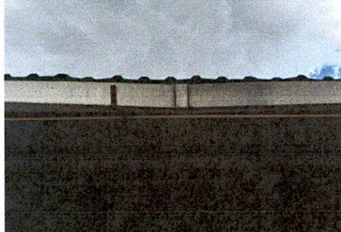
Módulo 2. Mantenimiento de costaneras y aplicación de pintura
