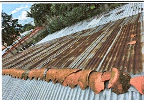
Módulo 2. Sustitución de láminas por láminas troqueladas calibre 26, láminas en mal estado que filtran agua a las aulas.
