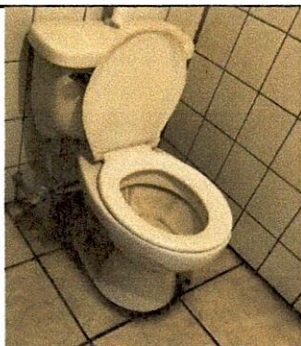
Módulo 2. Sustitución de sanitario en mal estado
