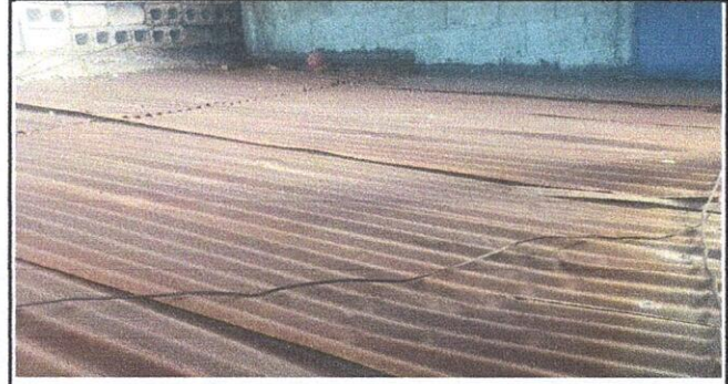
2. Sustitución de flashing, por flashing de lámina lisa calibre 26. Modulo 1 y 2. (36.00 ml).
