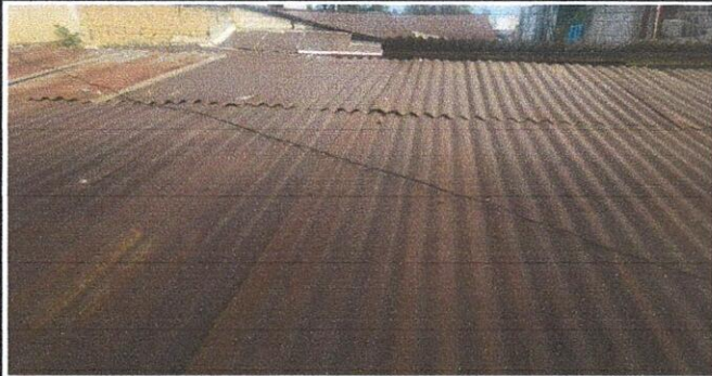
1. Sustitución de lámina, por lamina troquelada calibre 26. Modulo 1, 2 y 3. (217.00 m2).
