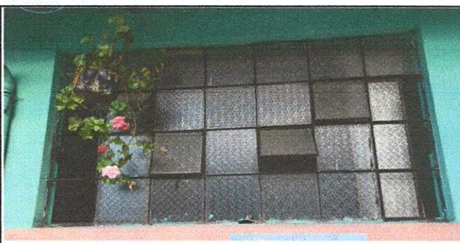
5. Sustitución de ventanas, por ventanas de PVC serie 8 y vidrio transparente de 5mm. Modulo 1. (13.00 m2).
