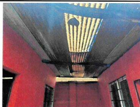
Mantenimiento correctivo con sustitución de estructura de madera y lámina ondulada por estructura de metal y lámina troquelada calibre 26
