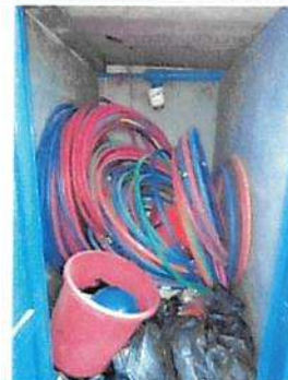
Mantenimiento correctivo a cubículo sanitario, cambio de tubería y reparación de muro de block
