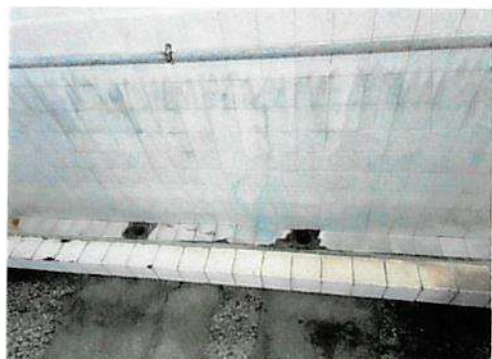
Mantenimiento correctivo a caja reposadera y tubería hg en urinal
