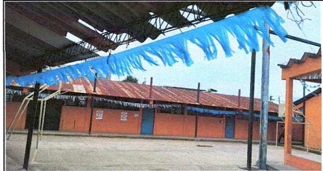
Mantenimiento a estructura portante antioxidante de color negro bloque 3 de un aula.
