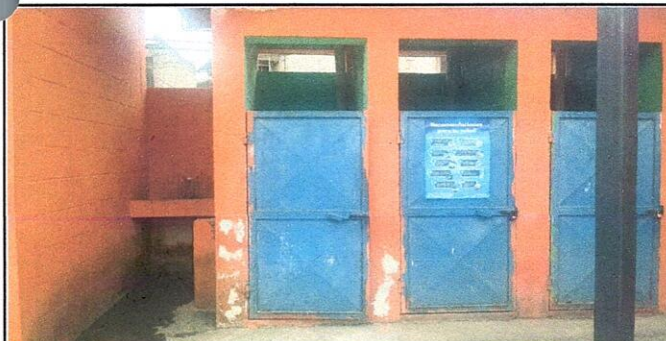
sustitución de dos puertas para baños a doble chapa de 0.80*210mts
