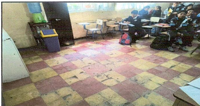
1. Sustitución de piso existente en siete aulas, por piso cerámico de formato tipo duela de 60 cm por 20 cm. En módulo 1 y 2 .
