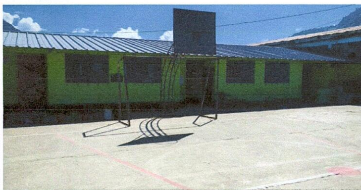
Sustitución de porterías de metal con medida de (2.00x2.00)m
