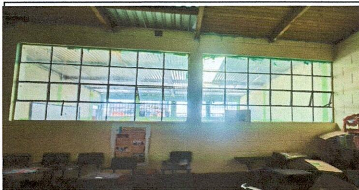
Mantenimiento para ventanas con 2 balcones de metal en aulas de módulo 1. (8m2)
