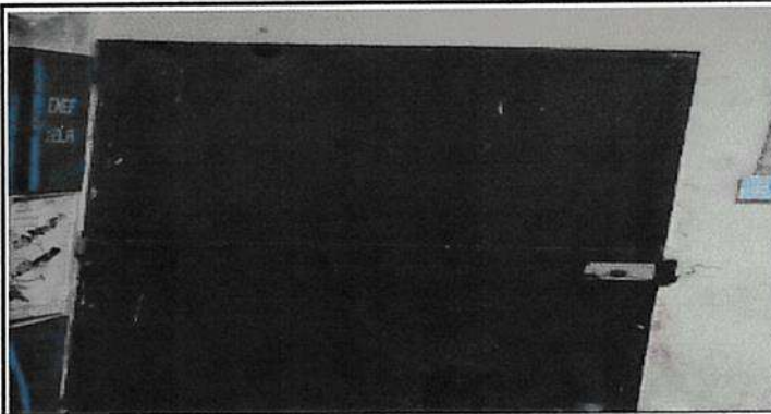
Mantenimiento de puerta, entrada en gimnasio 1er. nivel
