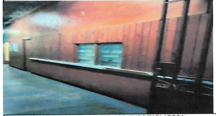
Sustitución de muro de madera por muro tablaroca
