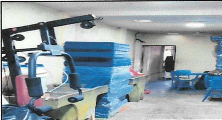
Aplicación de pintura interior en gimnasio de 1er. nivel
