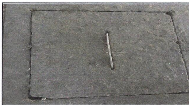
2. Sustitución de caja de registro, por caja de registro 0.60m x 0.60m x 0.80m.
