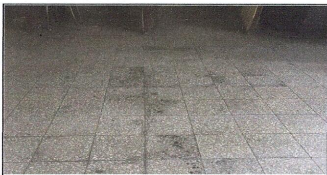
1. Sustitución de piso de granito, por piso de concreto en área de escenario
