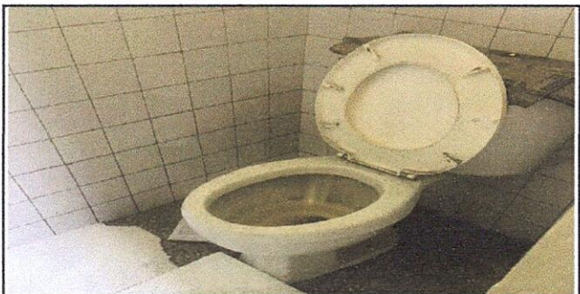
5. Sustitución de tasa sanitaria, por tasa sanitaria de marca reconocida.
