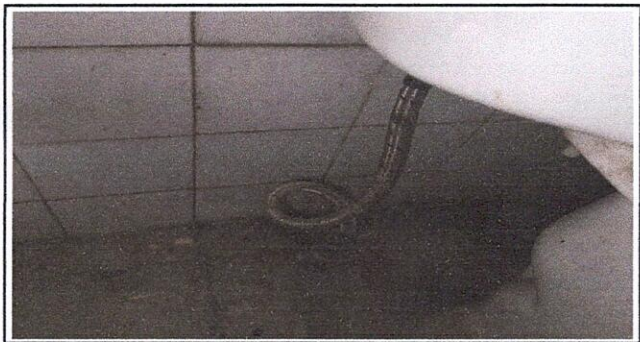
3. Sustitución de tubería de agua potable, por tubería de 3/4 de PVC 360 psi.
