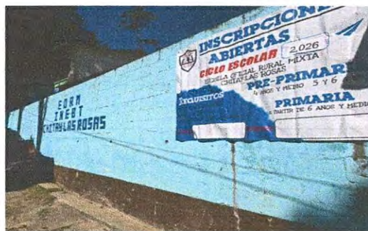
Foto. 16. Suministro y aplicación de pintura exterior latex (incluye rotulación con el nombre del establecimiento) marca corona clásica. 450 m2
