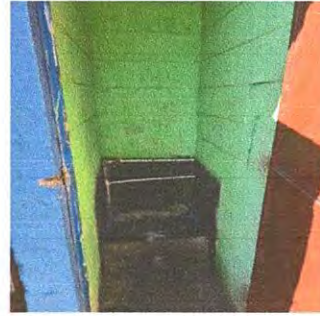
Foto 2. Sustitución de mingitorio de concreto con azulejo,
