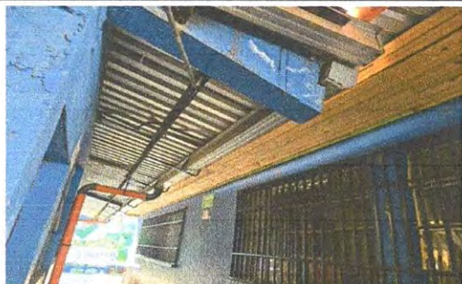
Foto 7. Suministro e instalación de lámparas tipo plafonera (incluye cableado y accesorios). 4 unidades
