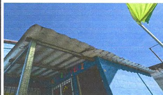
Foto 12. Suministro e instalación de lámina troquelada Aluzinc calibre 26 marca Promasa
