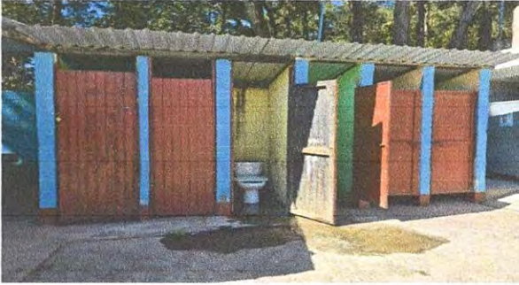
Foto 1. Sustitución de puertas de madera por puertas de metal chapa 16 para baños con pasador. 3 unidades
