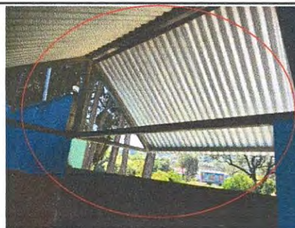
Foto. 18. Sustitución de lámina lisa en estructura superior en portón chapa 16 1.25 x 1.70
