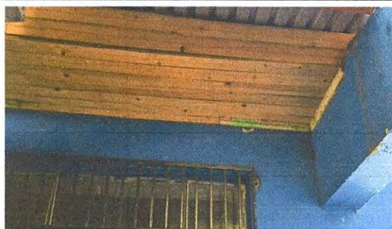
Foto 9. Suministro e instalación de lámparas para cielo falso tipo led (incluye cableado y accesorios) marca luxlite o sylvania
