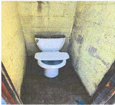
Foto 3. Sustitución de accesorios inodoro (contrallave, tubo de abasto, y pegado de inodoro)
