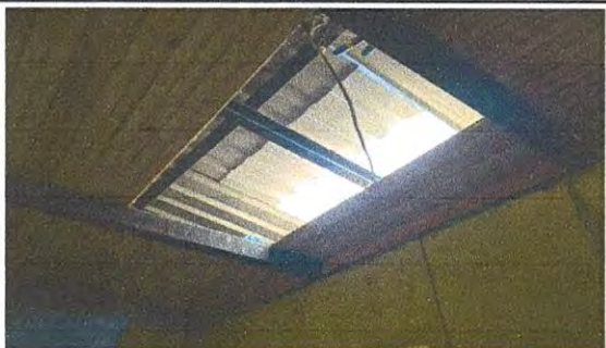
Foto. 13. Sustitución de difusor de pvc en cocina
