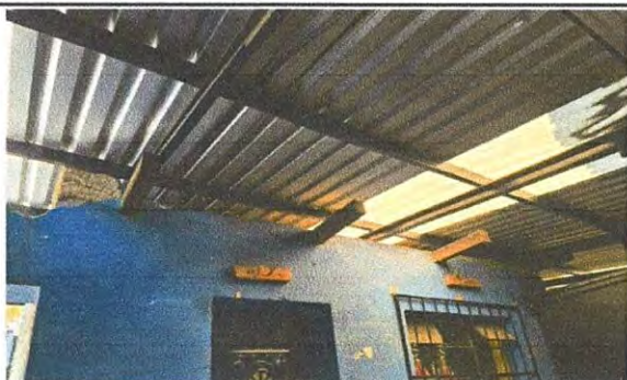
Foto. 15. Mantenimiento correctivo en techo con cielo falso PVC. 31 m2
