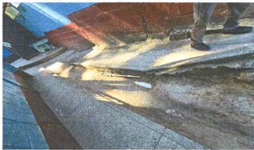
Foto 5. Mantenimiento de superficie tipo empañuelado para desnivel de agua en patio
