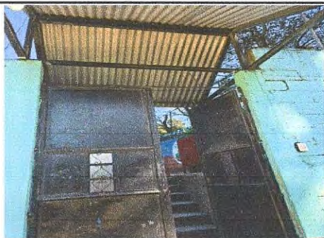
Foto. 17. Sustitución de portón de metal chapa 16 de 2 hojas 1.70 * 2.45 con ventanillas y chapa marca Yale y argollas para candados.
