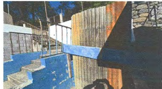
Foto 4. Sustitución de baranda de metal con tubo cuadrado de 3/4" chapa 16 con puerta 7.50 m2
