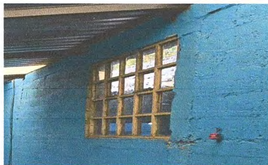
Foto 10. Suministro e instalación de vidrios para ventana de 5 mm. 20 Unidades
