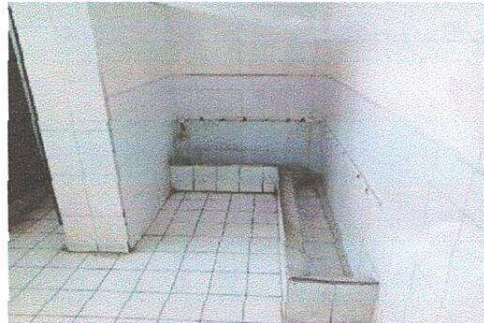
BAÑO DE NIÑOS: Sustitución de azulejo cerámico
