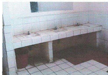
BAÑO DE NIÑOS: Sustitución de llave de lavamanos Sustitución de sifón para lavamanos
