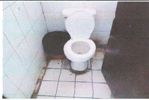
BAÑO DE NIÑAS: Sustitución de taza sanitaria
