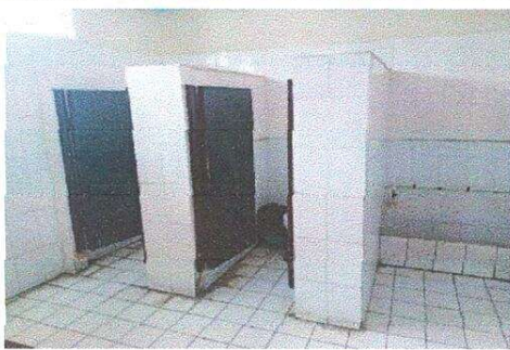
BAÑO DE NIÑOS: Sustitución de puertas por puertas metálicas Sustitución de división de PVC color blanco
