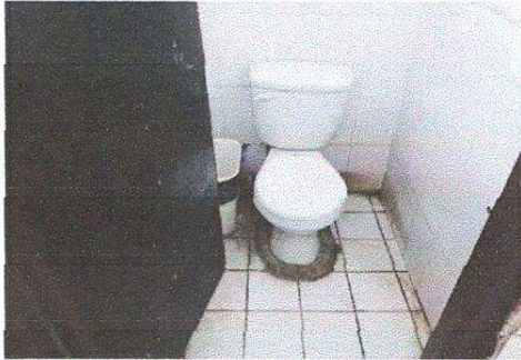
BAÑO DE NIÑOS: Sustitución de taza sanitaria Mantenimiento de tubería de drenaje
