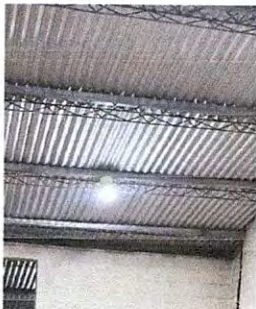
SUSTITUCIÓN DE LÁMPARAS TIPO LISTON, INCLUYE ENTUBADO, CABLEADO, SOPORTES Y TUBOS LED
