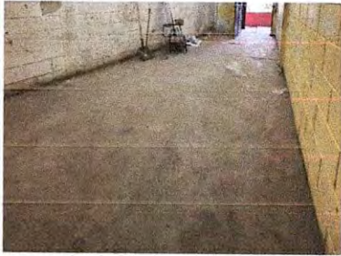
SUSTITUCIÓN DE PISO CERÁMICO INTERIOR
