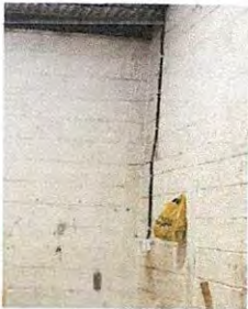
SUMINISTRO E INSTALACIÓN DE TOMACORRIENTES DOBLES (INCLUYE CABLEADO Y ENTUBADO)
