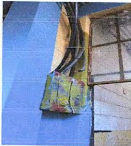
SUSTITUCIÓN DE TABLERO PRINCIPAL DE 3 FLIPONES
