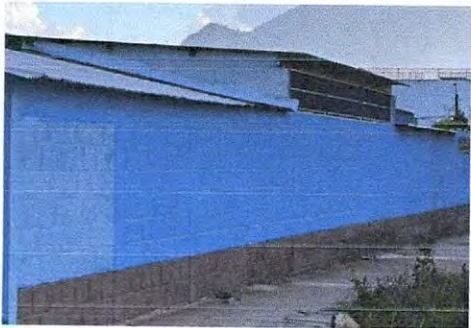
MANTENIMIENTO CORRECTIVO PARA ILUMINACION EN MURO CON ESTRUCTURA DE VENTANA Y SOPORTES DE STRUCTURA METALICA EN TECHO. PARA MANTENIMIENTO INLCUYE EL SUMINISTRO DE
