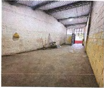
SUMINISTRO Y APLICACIÓN DE PINTURA INTERIOR LATEX LAVABLE (LIMPIEZA, RESANE Y APLICACIÓN) 160 M2
