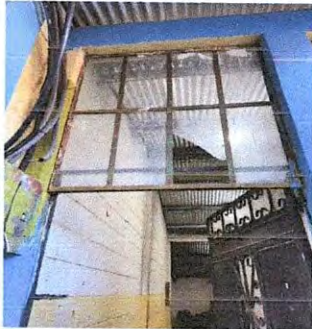
SUSTITUCIÓN A ESTRUCTURA DE METAL DE VENTANA DE INGRESO DE PUERTA, 2.40 m2; SUSTITUCION DE VIDRIOS 5 MM EN INGRESO DE PUERTA 2.00 UNIDAD
