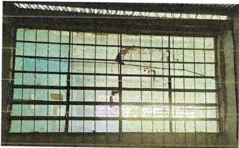
SUSTITUCIÓN DE VENTANAS INTERIORES POR VENTANAS METÁLICA CORREDIZAS CON VIDRIO NEVADO
