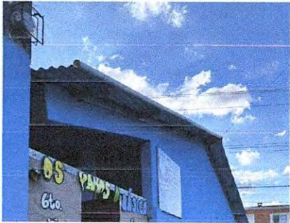
SUSTITUCIÓN DE VENTANA DE METAL PARA ZONA FRONTAL
