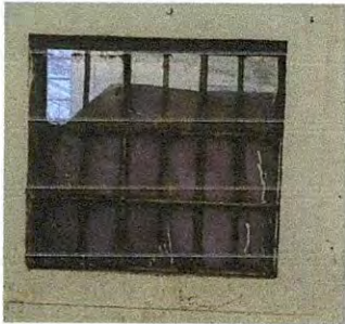
SUSTITUCIÓN DE VENTANAS INTERIORES POR VENTANAS METÁLICAS CORREDIZAS
