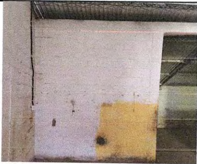
SUSTITUCION DE MURO DIVISORIO POR MURO DE TABLAYESO PARA CERRAMIENTO DE DIRECCIÓN
