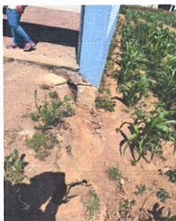
Mantenimiento correctivo de desplante de muro de portón de ingreso
