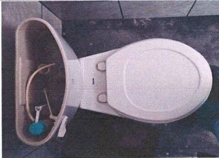
Sustitución de accesorios de tanque de inodoro (Kit de tanque de inodoro válvula de llenado, flapper de caucho, flotador de tanque)
