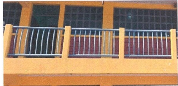
Mantenimiento a barandas de metal en pasillos (lijado, pintado anticorrosivo, y cambio de partes de perfiles dañados)
