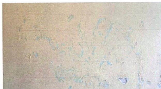
Mantenimiento de muros con repello impermeable y pintura.
