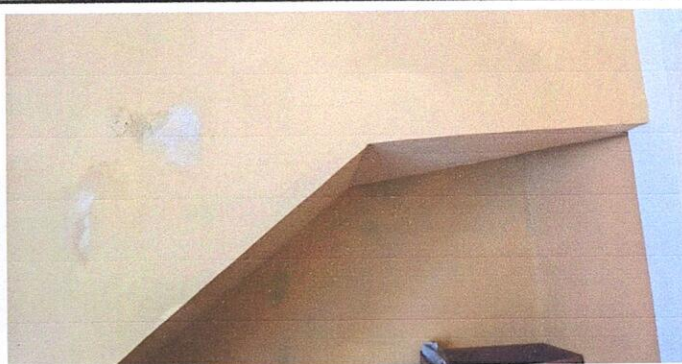
Mantenimiento de muros con repello impermeable y pintura.
