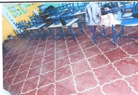
Mantenimiento de piso todo el piso de cemento líquido con lustrado y pulido
