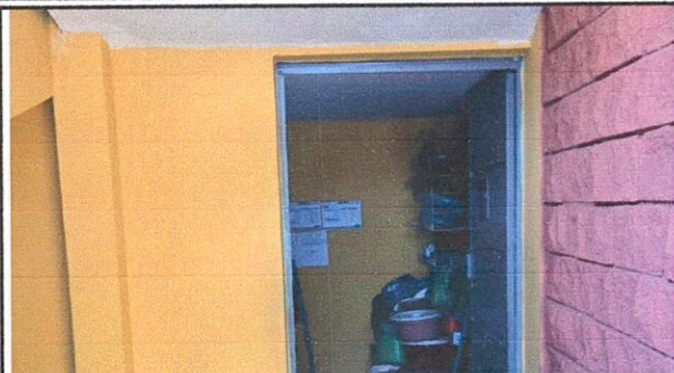
Mantenimiento correctivo de cocina con mueble fijación metálica y concreto
