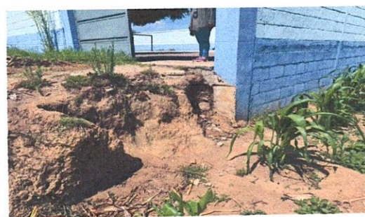
Mantenimiento correctivo de desplante de muro de portón de ingreso
