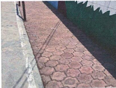
Reparación de piso con adoquín tráfico liviano decorativo
